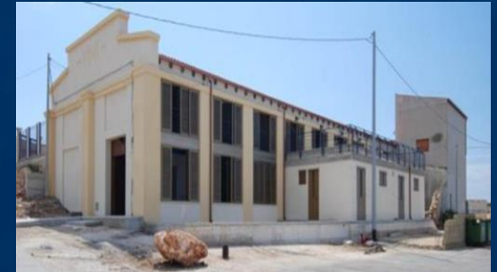
The shore station at Portopalo di Capo Passero
